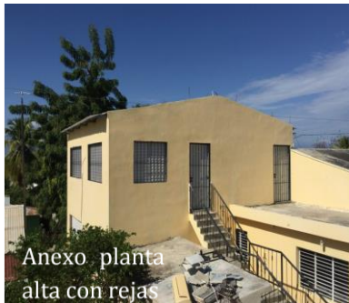
Obergeschoss des Nebengebäudes mit Schutzgittern
