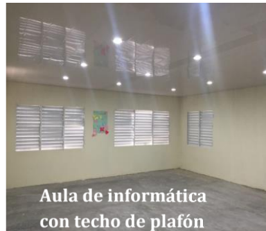
Informatik Schulungsraum mit Deckenverkleidung
