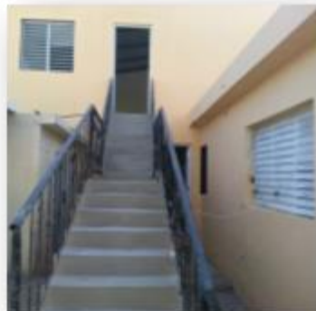
Treppe zum neuen Obergeschoss, rechts davon eines der neuen Klassenzimmer
